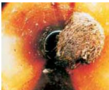
Bild 2 - Wurzeleinwuchs
